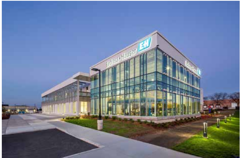
Das Endress+Hauser Kunden- und Schulungszentrum im kanadischen Burlington erzeugt mehr Energie, als es verbraucht.
